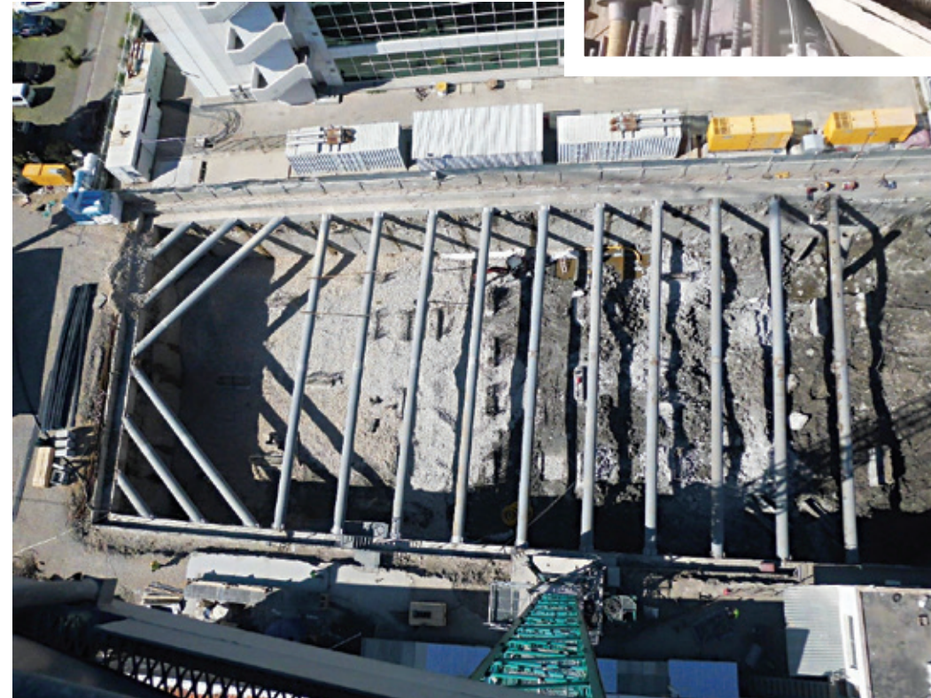
Diyafram perde ve sismik strut
