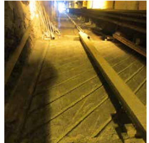
Taban betonu döküm işleri
