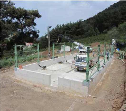
Atık alanı inşaatı
