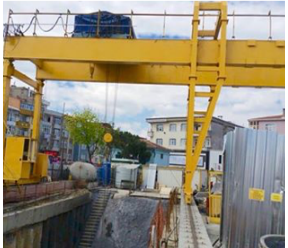
Akşemseddin Şantiyesi; portal çıkışı ve genel görünümü
