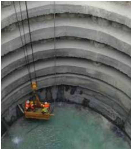
Özgürlük meydanı istasyonu Kuzey Şaftı enjeksiyon için hazırlık
