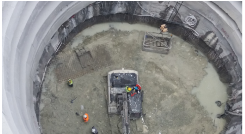
Kuzey Şaftında kazı çalışması
