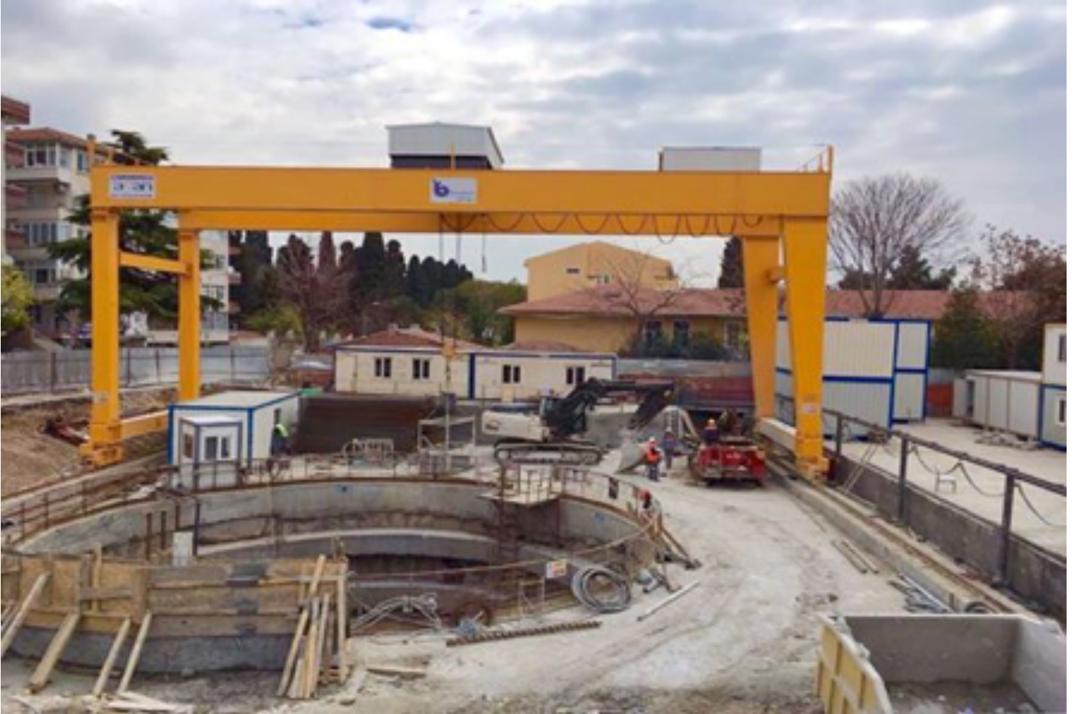
Bakırköy Kuzey Şaftı Şantiyesi; şaft üstü genel görünümü
