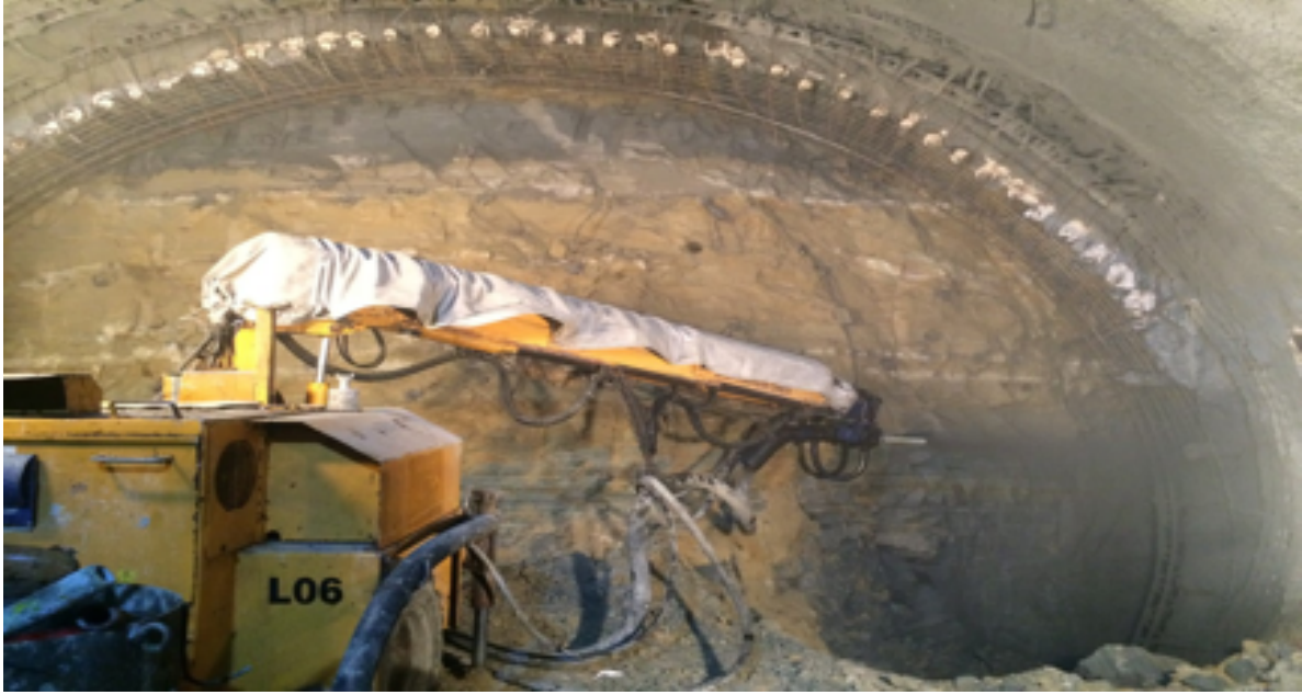
İhlasyuva Şantiyesi, Umbrella Arch yapılmış aynanın shotcrete uygulaması
