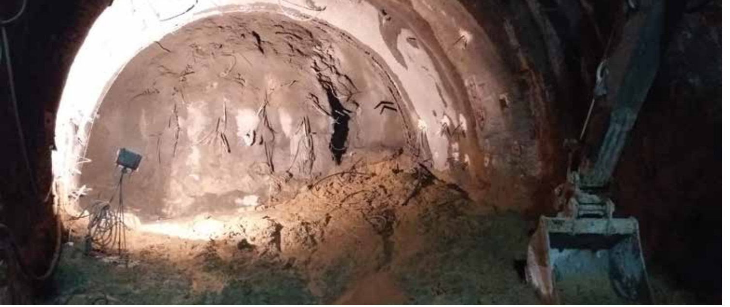
Doğu sanayi bağlantı aynasından kumlu malzeme akışı
