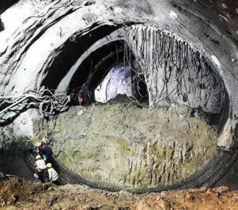
Yenibosna hat2 tüneline 3 aşamalı P1A4 tünel kazısı
