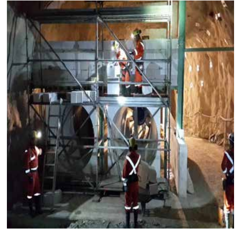
Egzoz fan montajı
