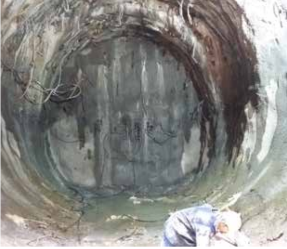
Kuzey Şaftı yaklaşım tünelinin susuzlaştırılmış son hali
