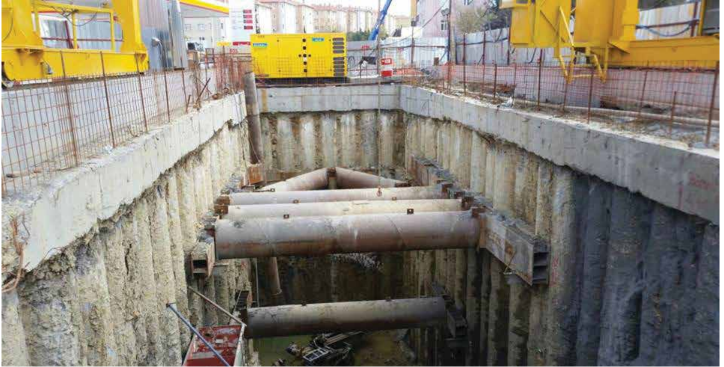
Akşemseddin Şantiyesi; shaft üstü ve portal girişi genel görünümü
