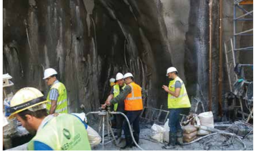
Kuzey Şaftında konsolidasyon enjeksiyonu çalışması
