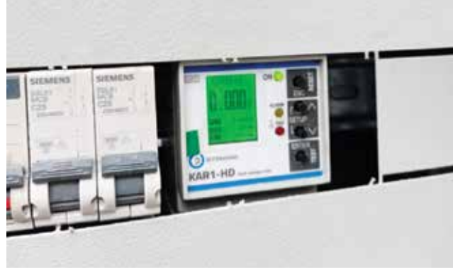
Makine besleme panosuna konulan 30 mA, 200 msn'lik harmonik filtreli dijital kaçak akım rölesi.
