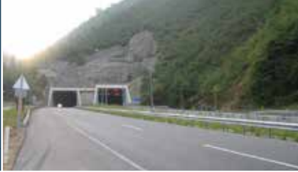
Karadeniz Otoyolu Perşembe - Bolaman Arası Nefise Akçelik Tüneli İnşaatı
