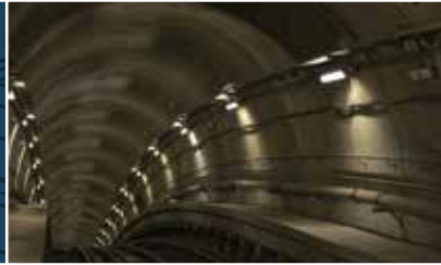
Taksim - Kabataş Füniküler Sistem İnşaatı
