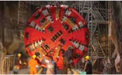
Ambarlı Atık Su Tünel İnşaatı
