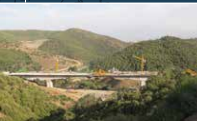
Tizi Ouzou Şehrini Djebahia Kavşağı Bölgesinde Doğu - Batı Otoyoluna Bağlayan 48 km Otoyol Yapım İşi
