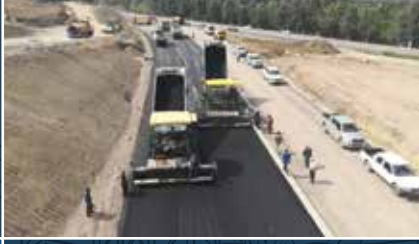
Tizi Ouzou Şehrini Djebahia Kavşağı Bölgesinde Doğu - Batı Otoyoluna Bağlayan 48 km Otoyol Yapım İşi
