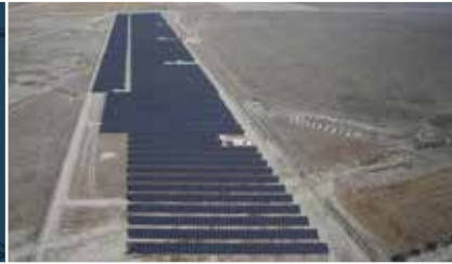
Güneş Enerji Santralleri
