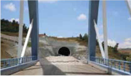
Thenia - Tizi Ouzou Çift Hat Demiryolu Yapım ve Elektrifikasyon İşleri
