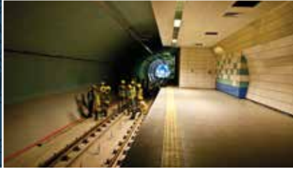
İstanbul Metrosu Kadıköy - Kartal Metro Projesi
